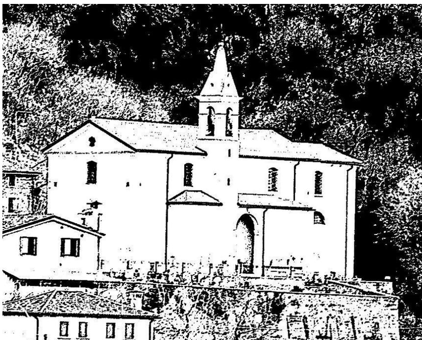
della stessa, costruita in cotto, che sostiene la pesante pietra nella quale è fissata la croce. La scarica elettrica ha poi fatto esplodere una parte del pilastro nord-ovest e divelto alcune coperture metalliche che coprono le cornici e il giunto con il tetto, con conseguenti infiltrazioni di acqua. Qualche mese dopo è stato eseguito un sommario intervento di rimozione delle parti pericolanti, ma senza procedere con il restauro.
